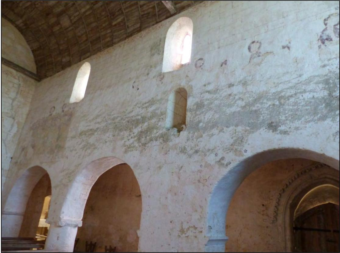
Figure n°15 : Norrey-en-Auge, église Sainte-Anne, nef, côté sud, principe des supports alternés, et élévation de la nef avec la baie antérieure débouchée surmontée de l'ouverture du XIII<sup>e</sup> siècle. Photo prise le 3 novembre 2016 par Roselyne Fouques.
