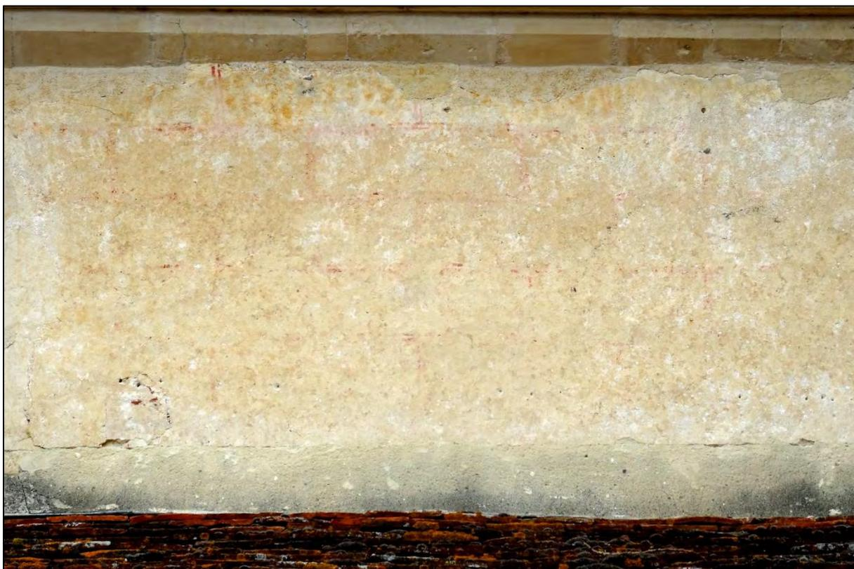
Figure n°48 : Norrey-en-Auge, église Sainte-Anne, mur sud extérieur de la nef, traces de faux-appareil à double joints verticaux et horizontaux orné d'une fleur noire. Photo prise par Vincent Cazin le 12 juin 2017.
