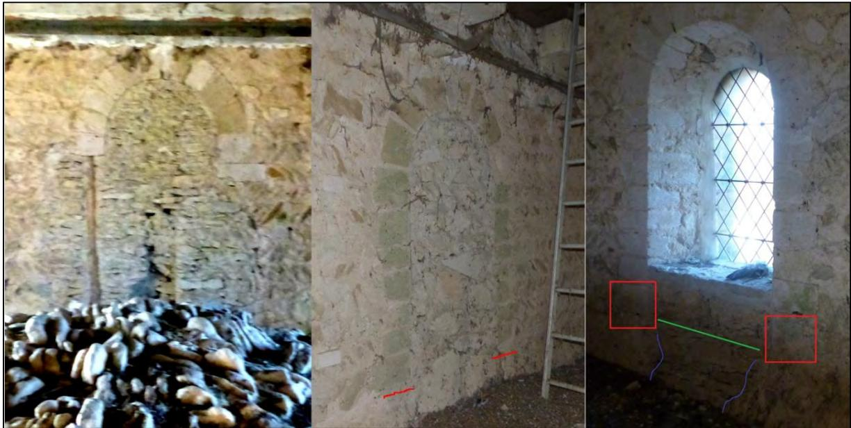
Figure n°27 : Norrey-en-Auge, église Sainte-Anne, clocher, baies romanes ouest et est rebouchées, baie romane nord : essai de reconstitution du niveau primitif en rouge les claveaux avec l'appui en vert et en bleu limite de l'appareillage en *opus spicatum*. Photos prises le 5 novembre 2016 et le 18 décembre 2017. Montage : Roselyne Fouques.
